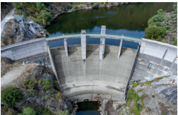
Kleinwasserkraftwerke „Sagres“, Portugal
